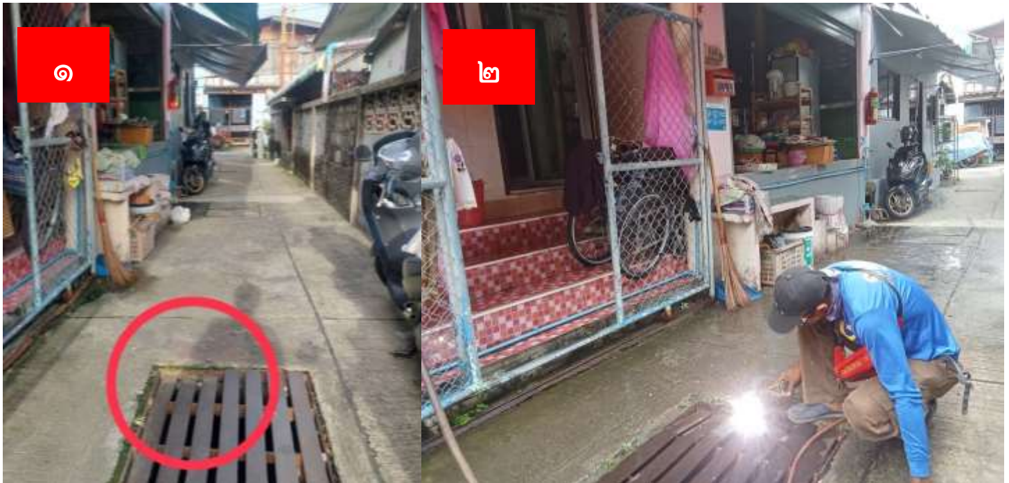
ภาพที่ ๑ ฝายบ่อบริเวณบ้านเลขที่ ๕๖๓ ก่อนดำเนินการแก้ไข ภาพที่ ๒ บริเวณบ้านเลขที่ ๕๖๓ ขณะดำเนินการแก้ไขแล้ว
